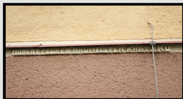
Nápis „Robert Peuker Baumeister Kratzau“ na omítce zvýšeného suterénu budovy.
