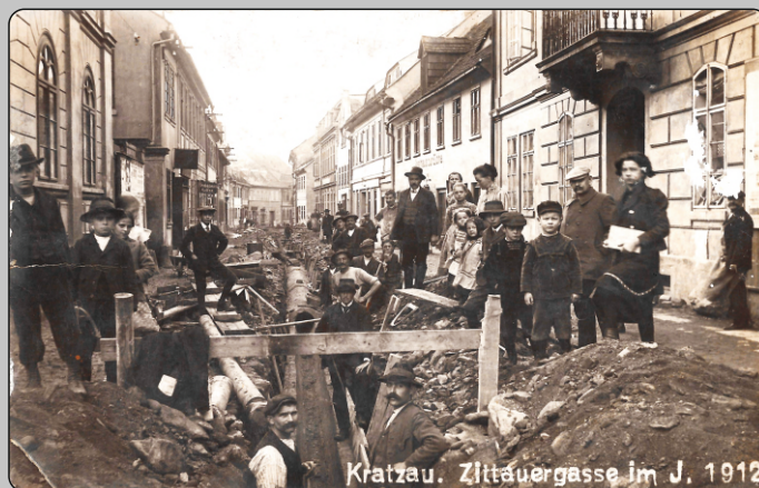
Stavba vodovodu Žitavskou ulicí k náměstí.
